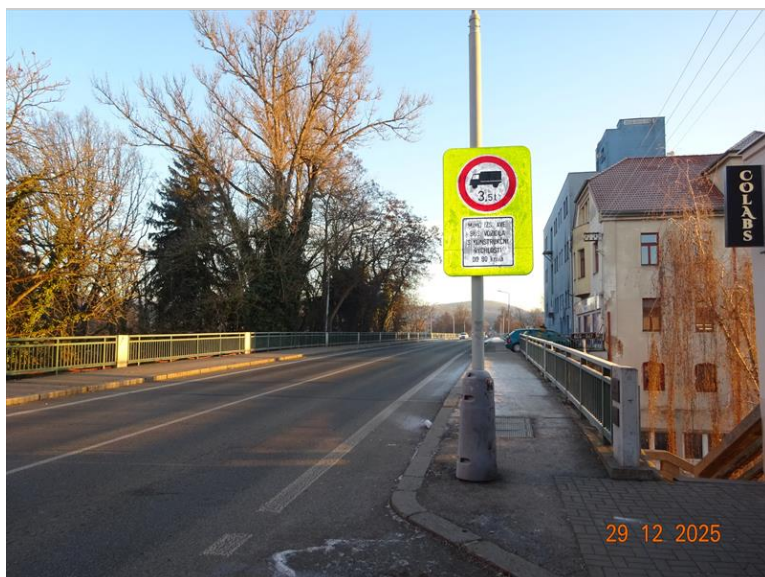
58_omezeni zatizitelnosti mostu proti st.JPG
