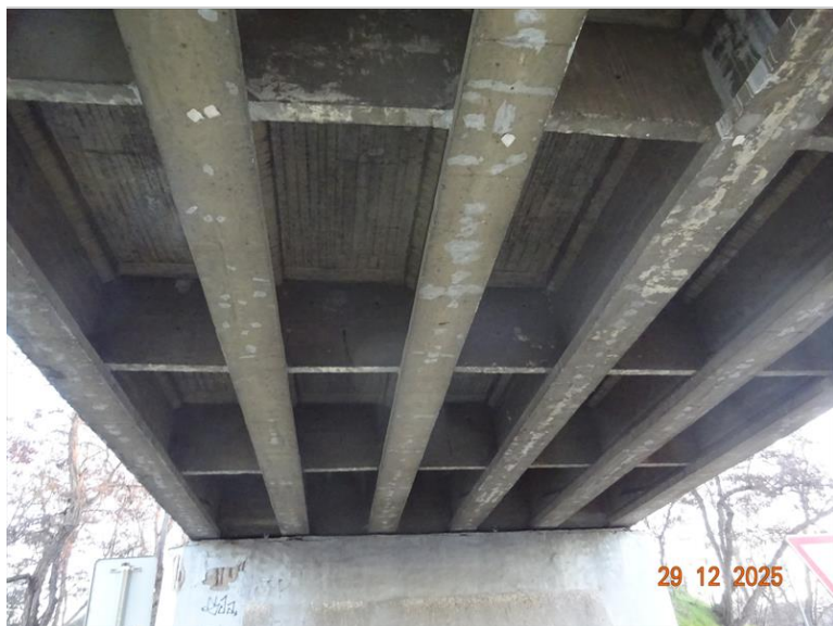
20_pohled NK pole 1.JPG
