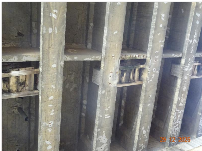
23_pohled NK pole 5.JPG
