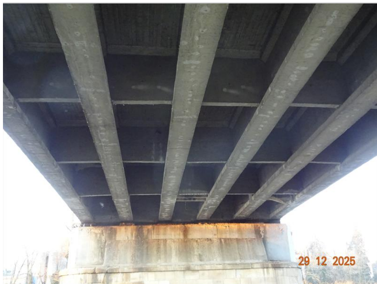
22_pohled NK pole 3.JPG
