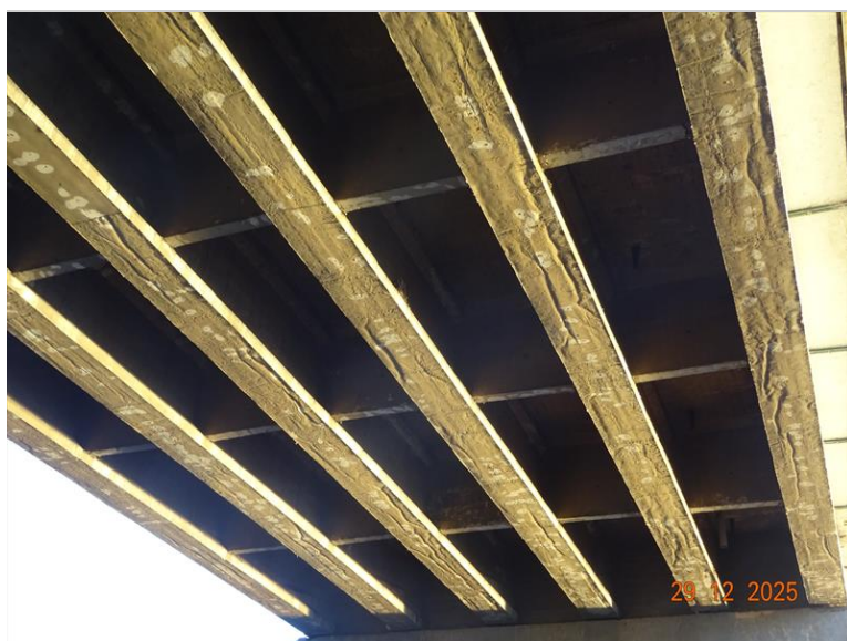
23a_pohled NK pole 6.JPG
