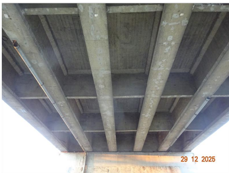
21_pohled NK pole 2.JPG
