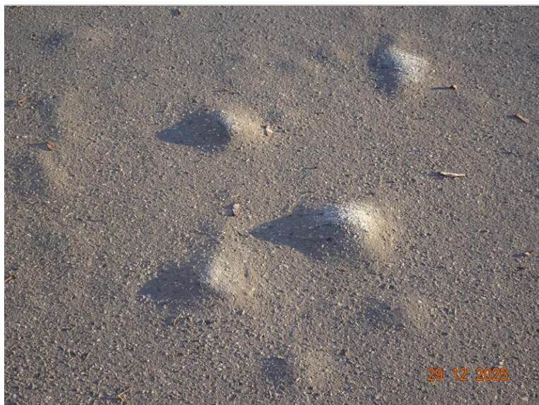
44_nerovnosti v krytu chodniku.JPG
