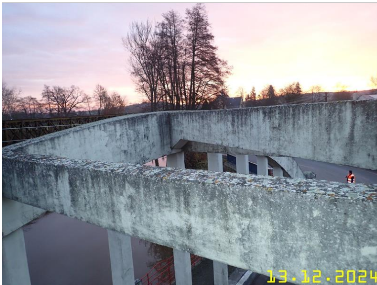
127 NOSNÁ KONSTRUKCE Z PLOŠINY .JPG
