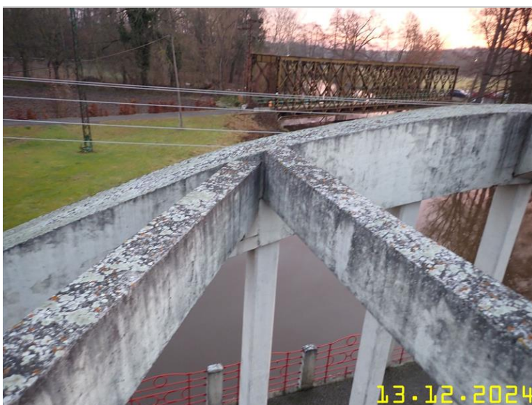
140 NOSNÁ KONSTRUKCE Z PLOŠINY .JPG
