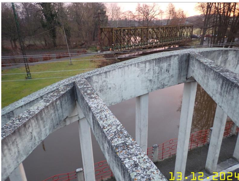
143 NOSNÁ KONSTRUKCE Z PLOŠINY.JPG
