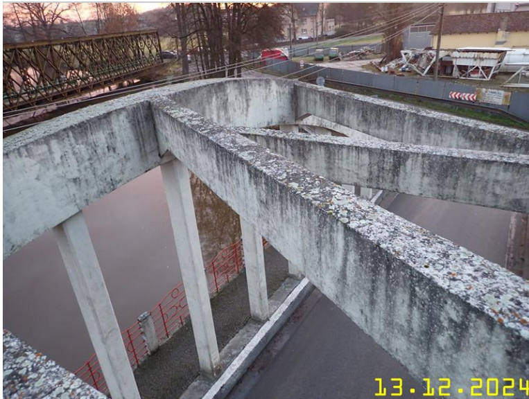
142 NOSNÁ KONSTRUKCE Z PLOŠINY.JPG
