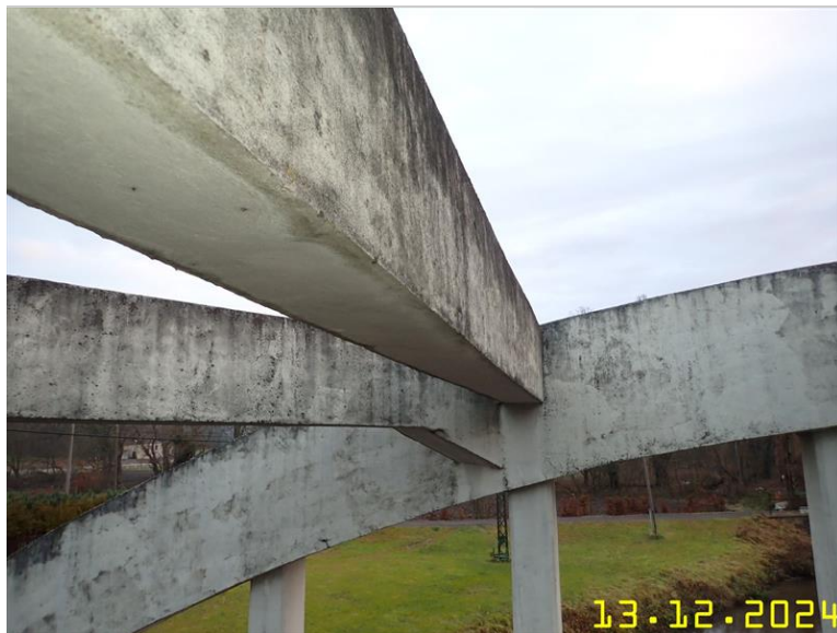
168 NOSNÁ KONSTRUKCE Z PLOŠINY .JPG
