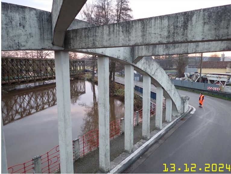
171 NOSNÁ KONSTRUKCE Z PLOŠINY .JPG
