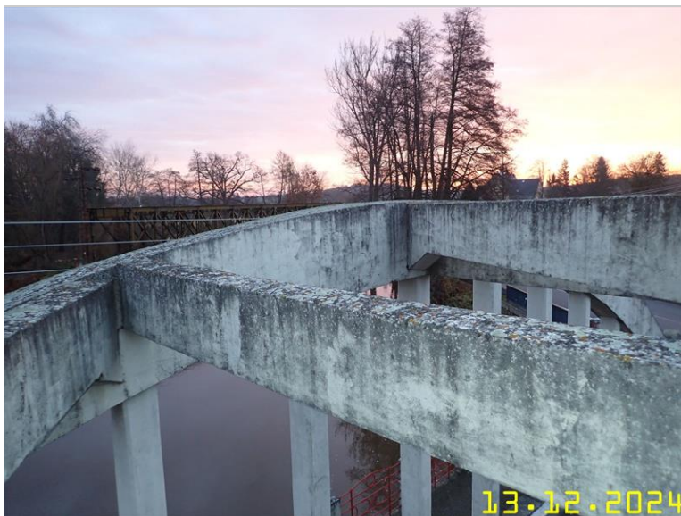
128 NOSNÁ KONSTRUKCE Z PLOŠINY .JPG
