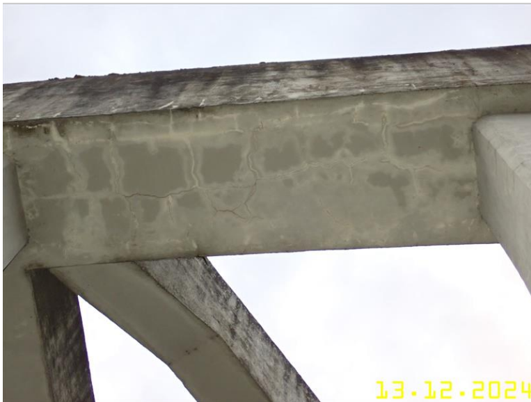
181 NOSNÁ KONSTRUKCE Z FLOŠINY.JPG
