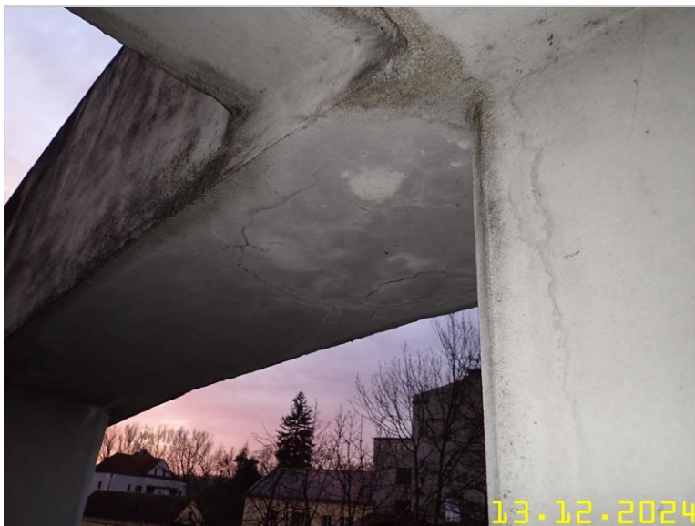
152 NOSNÁ KONSTRUKCE Z FLOŠINY .JPG
