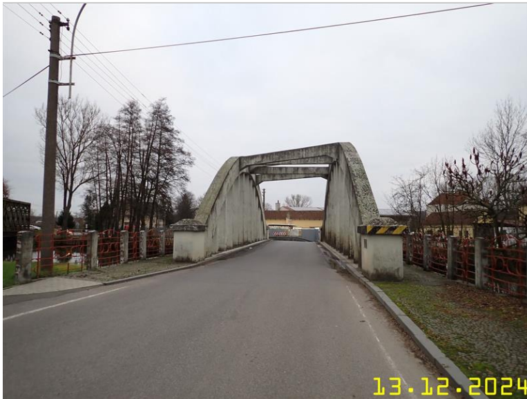
002 PROSTOROVÉ USPOŘÁDÁNÍ NA MOSTU V POHLEDU PO SMĚRU STANIČENÍ.JPG
