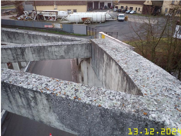
141 NOSNÁ KONSTRUKCE Z PLOŠINY.JPG
