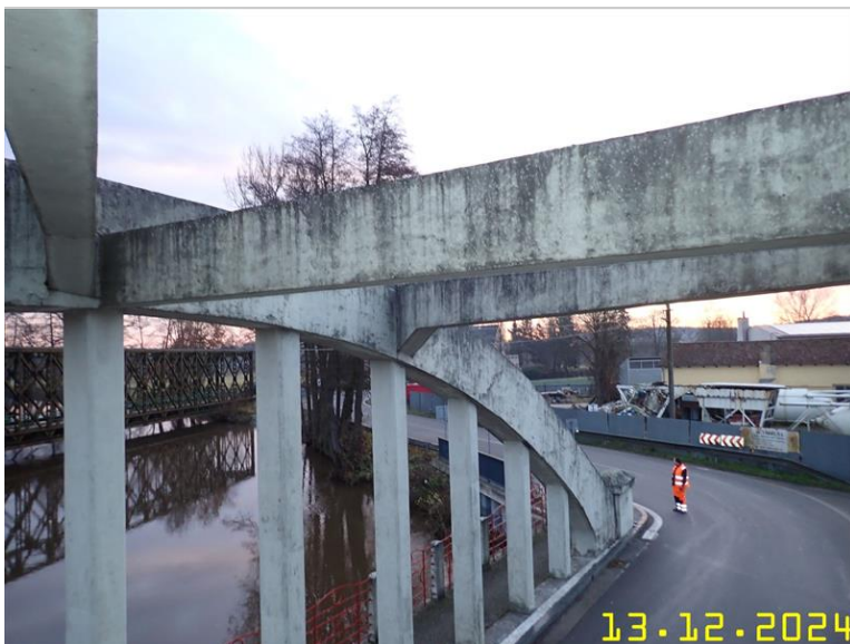
167 NOSNÁ KONSTRUKCE Z PLOŠINY .JPG
