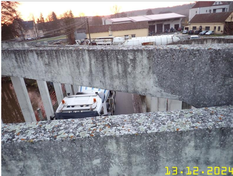
130 NOSNÁ KONSTRUKCE Z PLOŠINY.JPG
