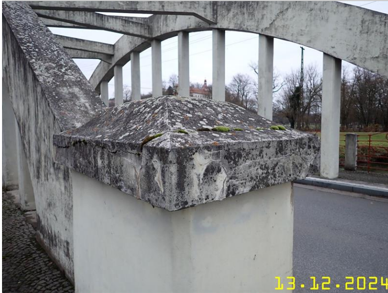
021 OBLOUK NA PRAVÉ STRANĚ PROTI SMĚRU STANIČENÍ.JPG
