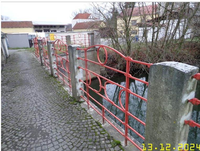
017 ZÁBRADLÍ NA PRAVÉ STRANĚ TĚMĚŘ U OPĚRY O2.JPG
