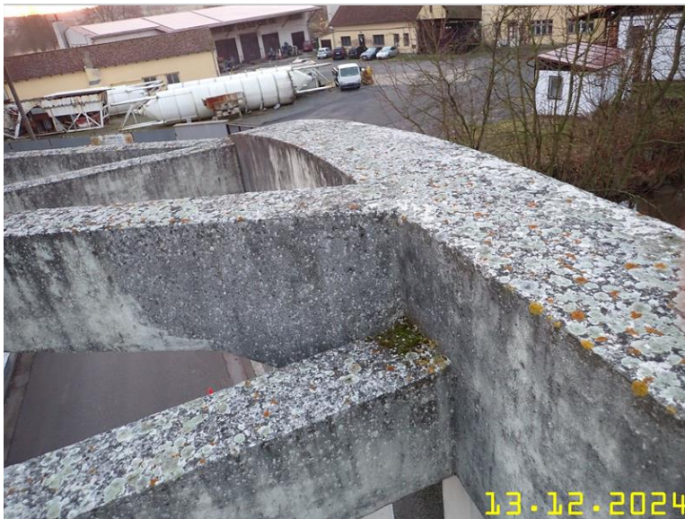
134 NOSNÁ KONSTRUKCE Z PLOŠINY.JPG
