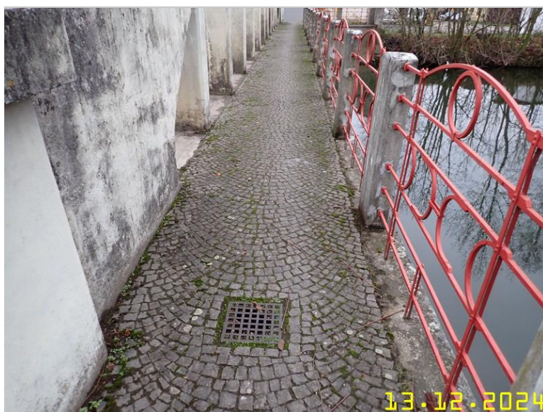
005 CHODNÍK NA PRAVÉ STRANĚ MOSTU.JPG
