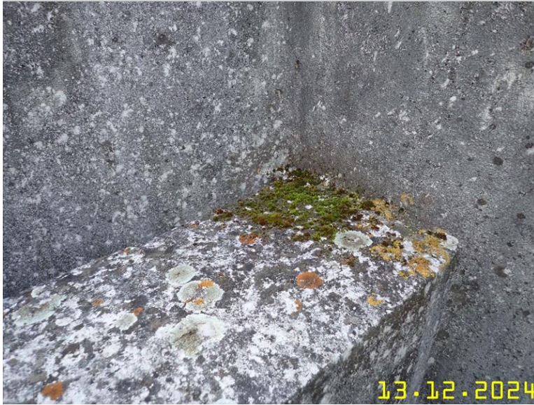
144 NOSNÁ KONSTRUKCE Z PLOŠINY.JPG
