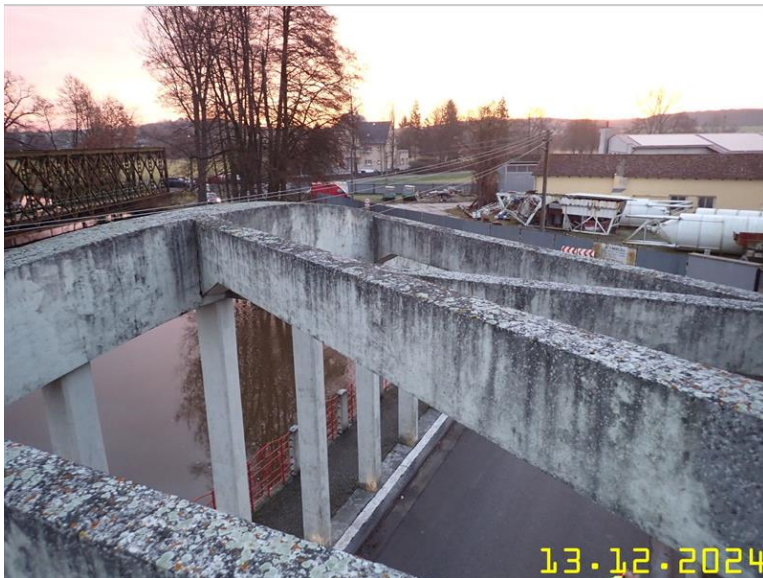
139 NOSNÁ KONSTRUKCE Z PLOŠINY .JPG
