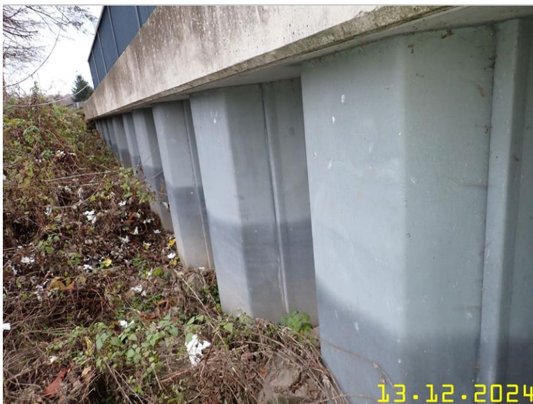
113 PŘÍLEHLÁ ZĚŇ K OPĚŘE O2 VLEVO.JPG
