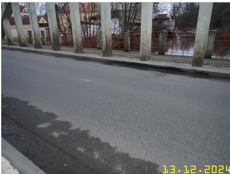
104 VOZOVKA NA MOSTĚ.JPG
