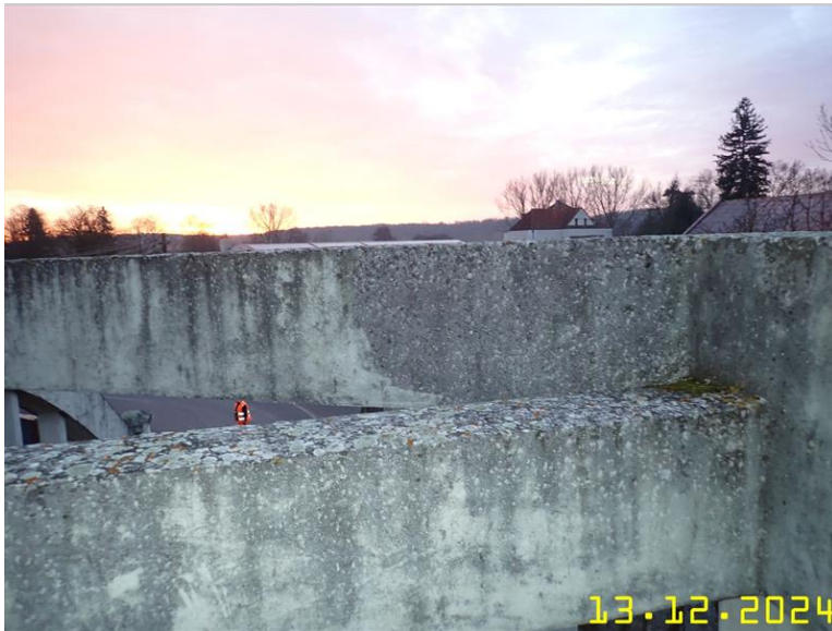
126 NOSNÁ KONSTRUKCE Z PLOŠINY .JPG
