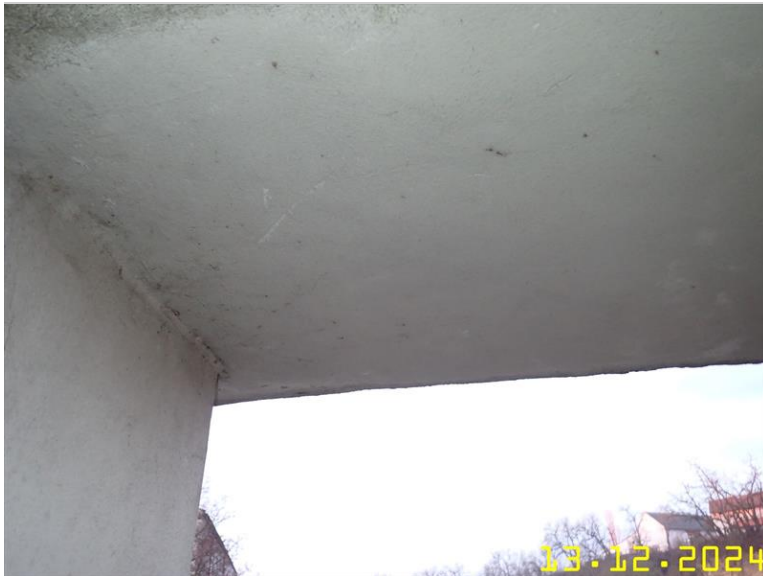
154 NOSNÁ KONSTRUKCE Z PLOŠINY .JPG
