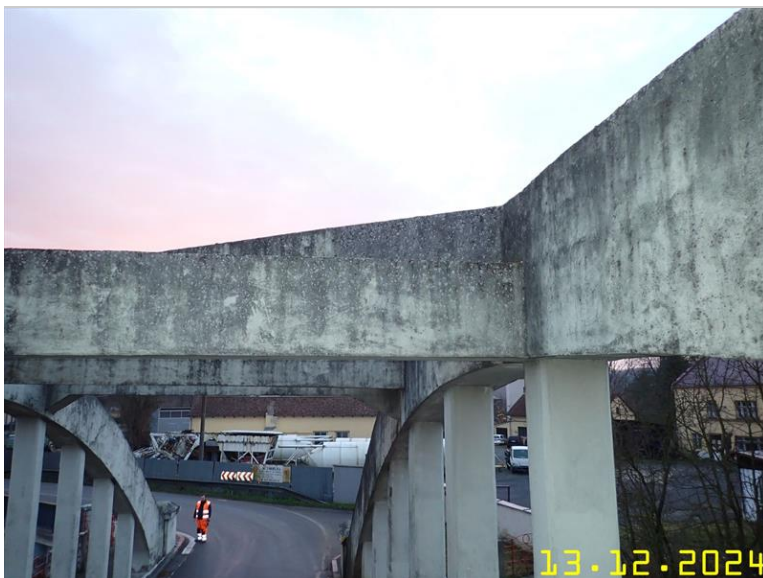
122 NOSNÁ KONSTRUKCE Z PLOŠINY .JPG
