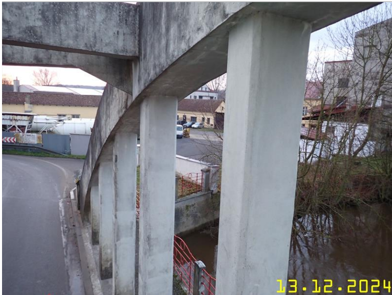
172 NOSNÁ KONSTRUKCE Z PLOŠINY .JPG
