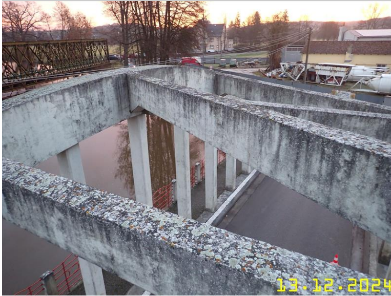
135 NOSNÁ KONSTRUKCE Z PLOŠINY .JPG
