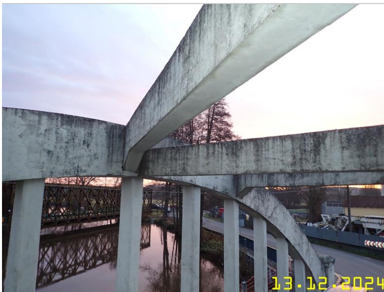
155 NOSNÁ KONSTRUKCE Z PLOŠINY .JPG
