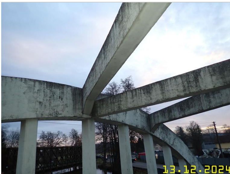
176 NOSNÁ KONSTRUKCE Z PLOŠINY .JPG
