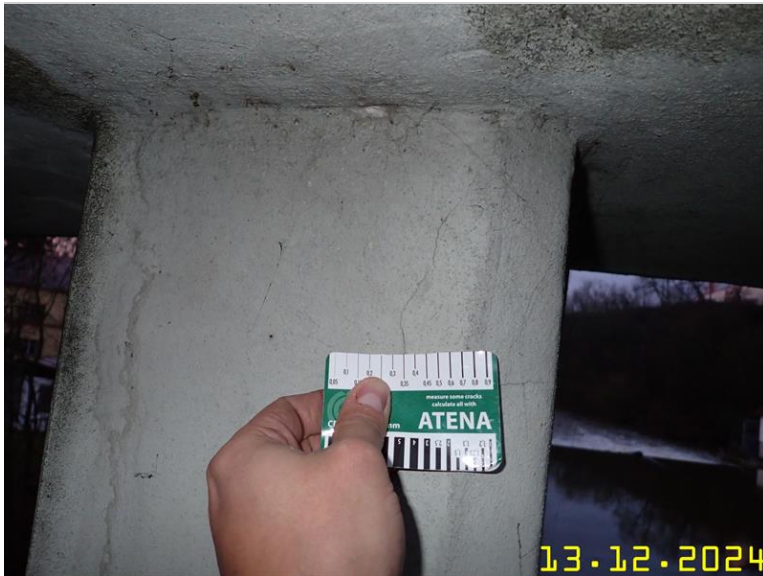
151 NOSNÁ KONSTRUKCE Z FLOŠINY .JPG
