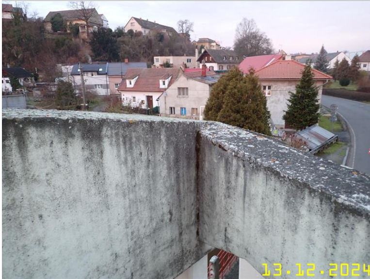
124 NOSNÁ KONSTRUKCE Z PLOŠINY.JPG
