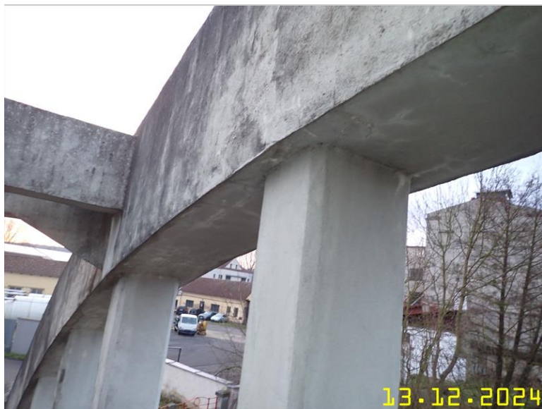
164 NOSNÁ KONSTRUKCE Z PLOŠINY.JPG
