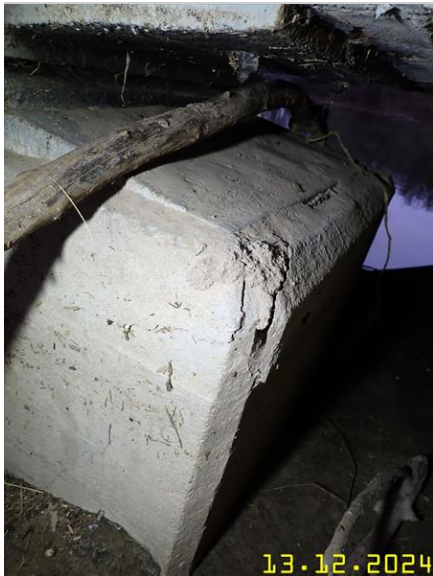
082 NEČISTOTY NA ULOŽENÍ 01.JPG
