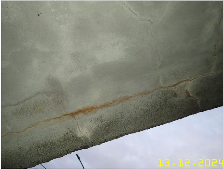
180 NOSNÁ KONSTRUKCE Z FLOŠINY.JPG
