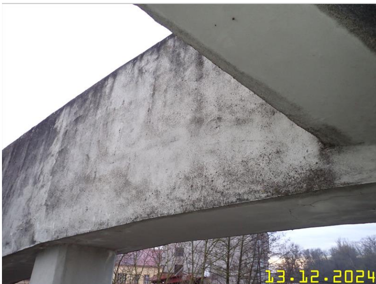
173 NOSNÁ KONSTRUKCE Z PLOŠINY .JPG
