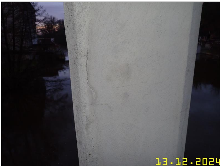
158 NOSNÁ KONSTRUKCE Z PLOŠINY .JPG
