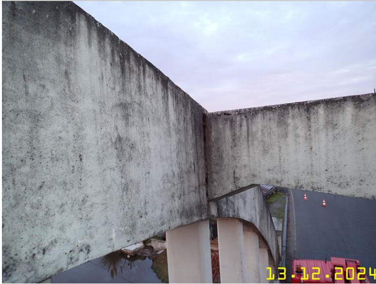
147 NOSNÁ KONSTRUKCE Z PLOŠINY.JPG
