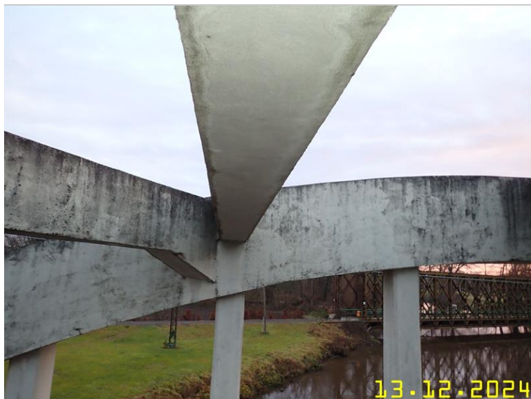
160 NOSNÁ KONSTRUKCE Z PLOŠINY.JPG
