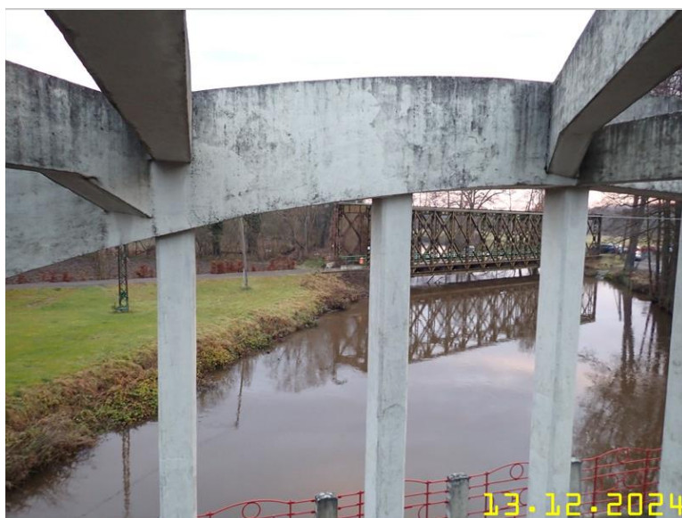
170 NOSNÁ KONSTRUKCE Z PLOŠINY .JPG
