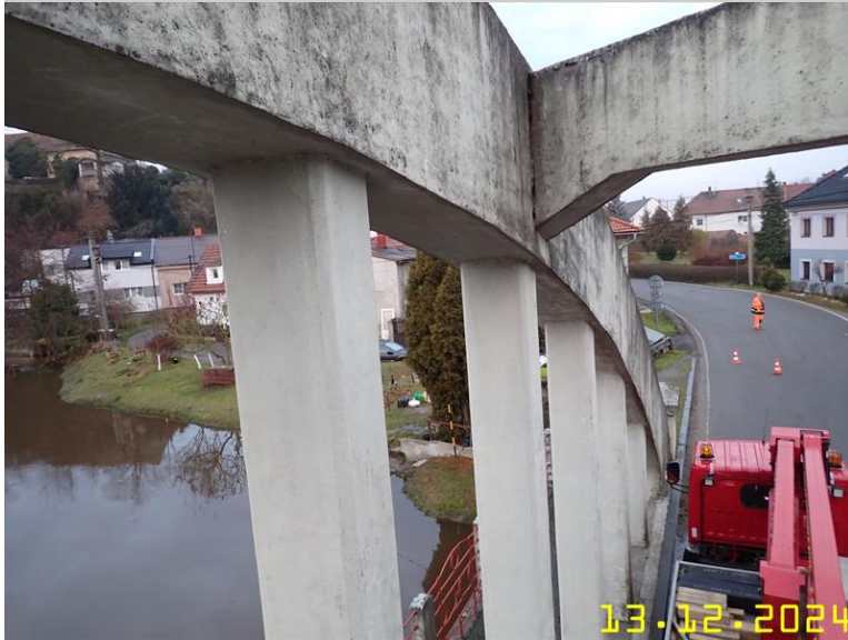
174 NOSNÁ KONSTRUKCE Z PLOŠINY .JPG
