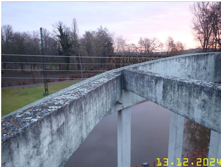
125 NOSNÁ KONSTRUKCE Z PLOŠINY.JPG
