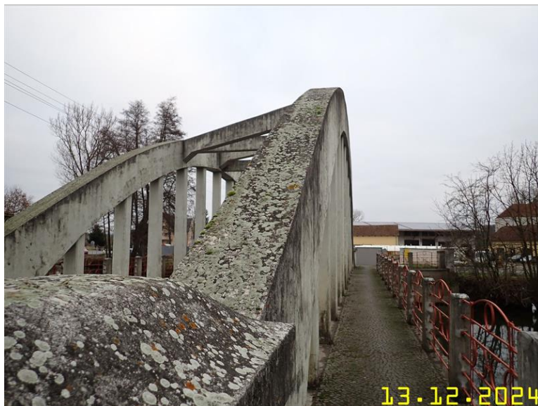
007 HORNÍ POVRCH PRAVÉHO OBLOKU CCA U OPĚRY O1.JPG
