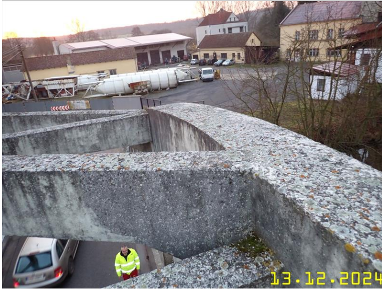
138 NOSNÁ KONSTRUKCE Z PLOŠINY .JPG
