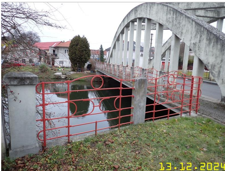
023 PRAVÁ STRANA MOSTU.JPG
