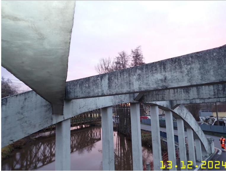
123 NOSNÁ KONSTRUKCE Z PLOŠINY.JPG
