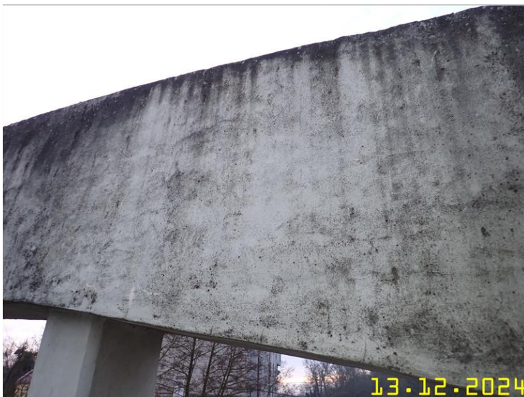
119 NOSNÁ KONSTRUKCE Z PLOŠINY.JPG
