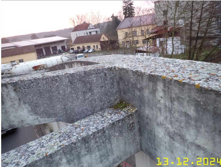
129 NOSNÁ KONSTRUKCE Z PLOŠINY.JPG
