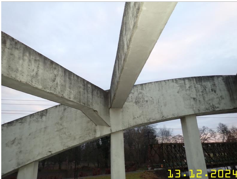
175 NOSNÁ KONSTRUKCE Z PLOŠINY .JPG
