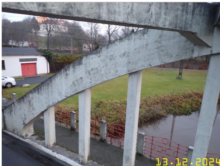
169 NOSNÁ KONSTRUKCE Z PLOŠINY .JPG
