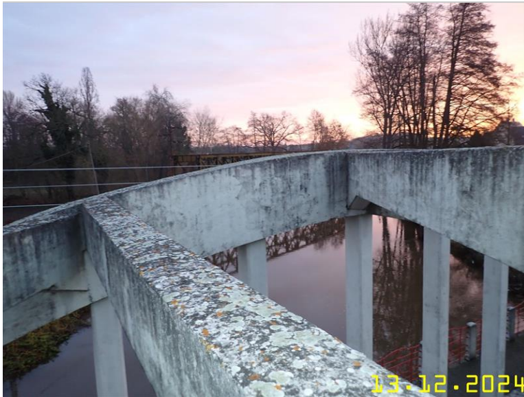
145 NOSNÁ KONSTRUKCE Z PLOŠINY.JPG
