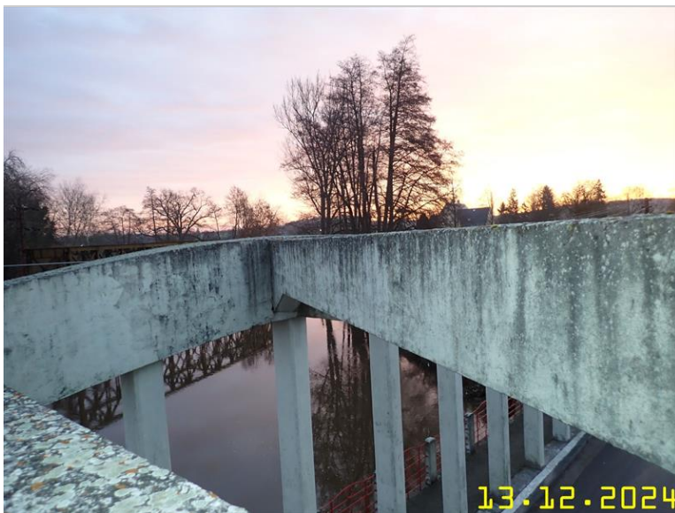
146 NOSNÁ KONSTRUKCE Z PLOŠINY.JPG
