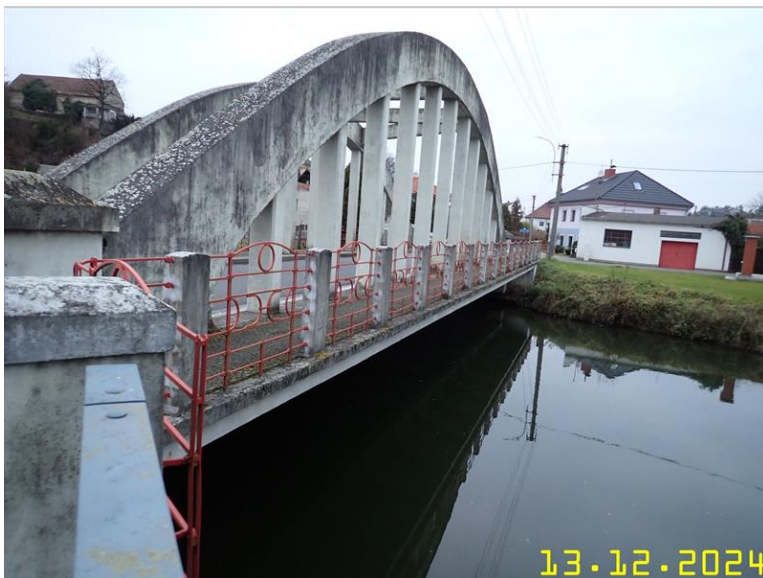
116 LEVÁ ŘÍMSA V POHLEDU PROTI SMĚRU STANIČENÍ.JPG
