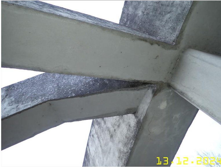
177 NOSNÁ KONSTRUKCE Z FLOŠINY.JPG
