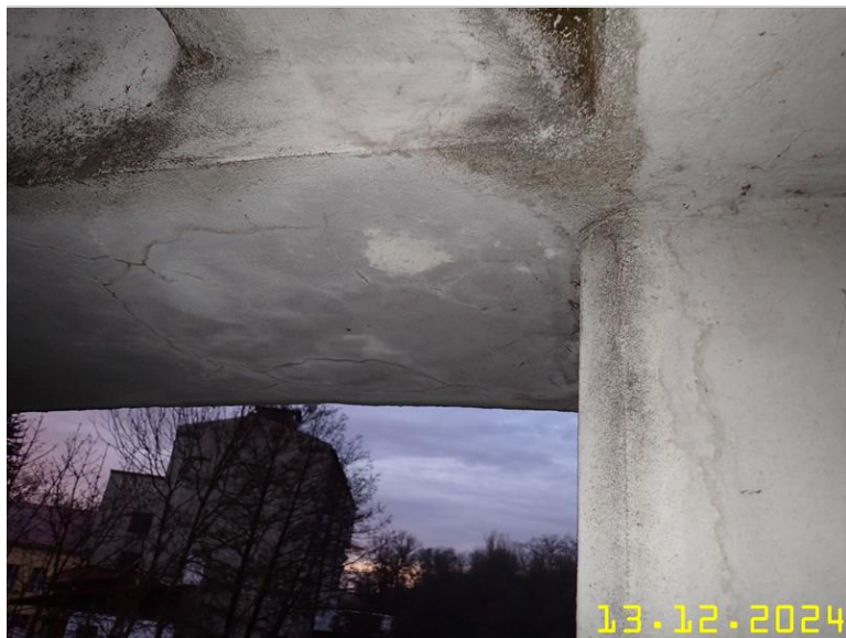
159 NOSNÁ KONSTRUKCE Z PLOŠINY.JPG
