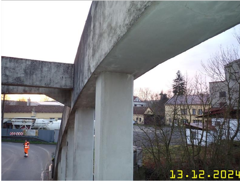
153 NOSNÁ KONSTRUKCE Z PLOŠINY .JPG
