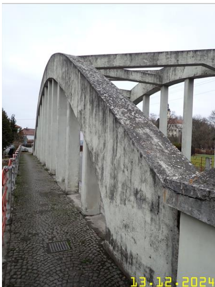
020 HORNÍ POVRCH OBLOUKU NA PRAVÉ STRANĚ Z POHLEDU PROTI SMĚRU STANIČENÍ.JPG
