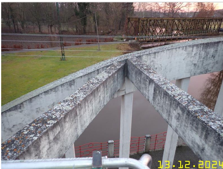
137 NOSNÁ KONSTRUKCE Z PLOŠINY .JPG
