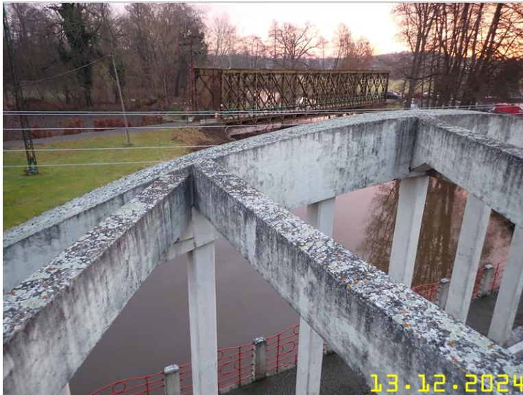
136 NOSNÁ KONSTRUKCE Z PLOŠINY .JPG
