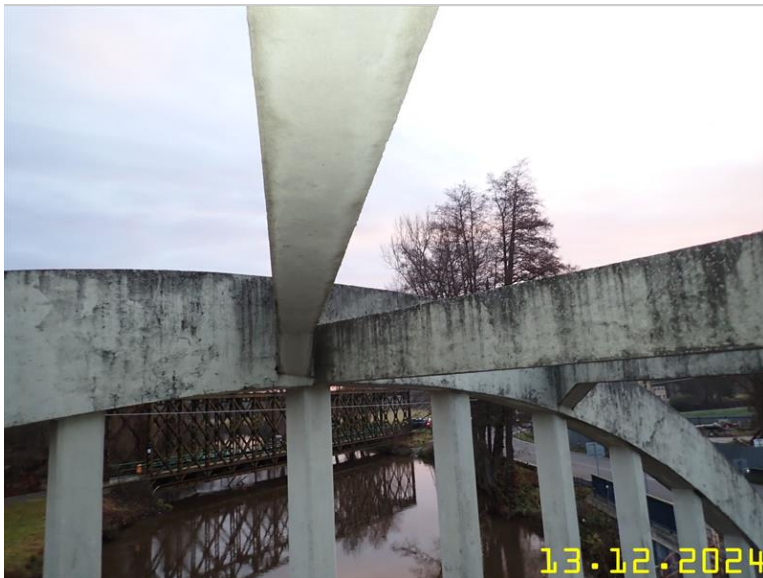
166 NOSNÁ KONSTRUKCE Z PLOŠINY .JPG
