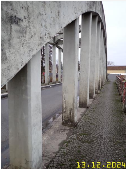
010 POHLED NA PRAVÝ OBLOUK Z CHODNÍKU A ZÁVĚSY OCA U OPĚRY O1.JPG
