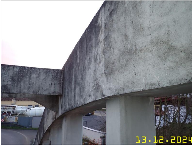
165 NOSNÁ KONSTRUKCE Z PLOŠINY .JPG
