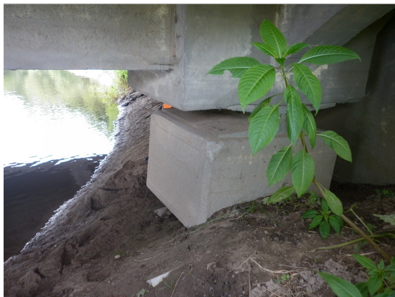
Pohled na levý kyvný blok na OP1
