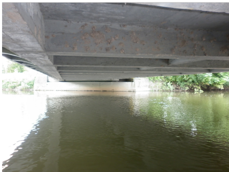
Pohled pod mostem od OP1
