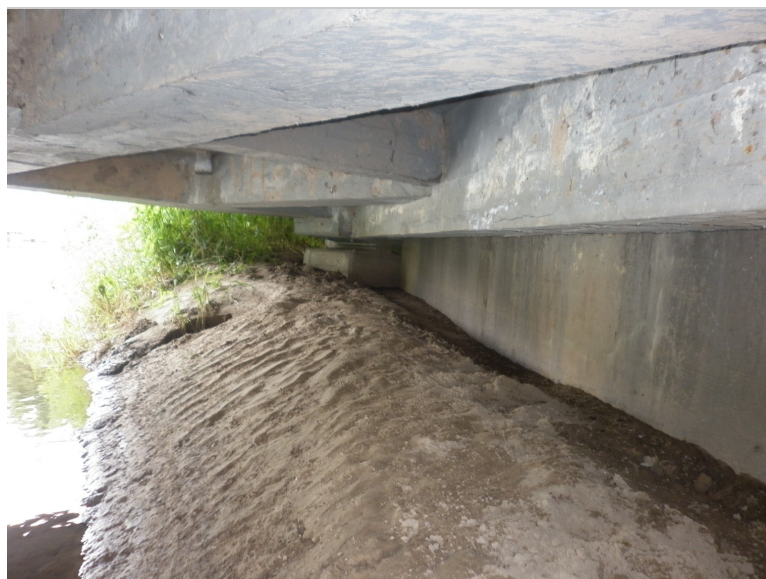
Pravý kyvný blok na OP1
