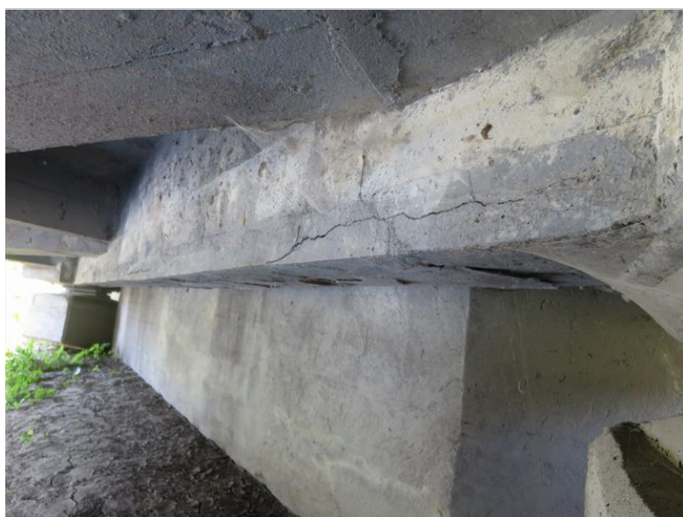
poruchy sanace na boku podporového příčniku nad O1
