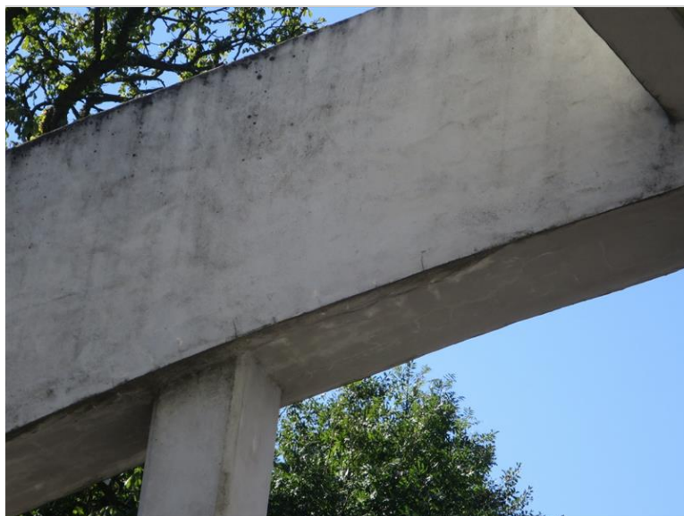
DTTO - na boku obloukového pasu
