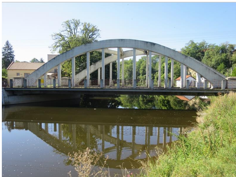
pohled na most
