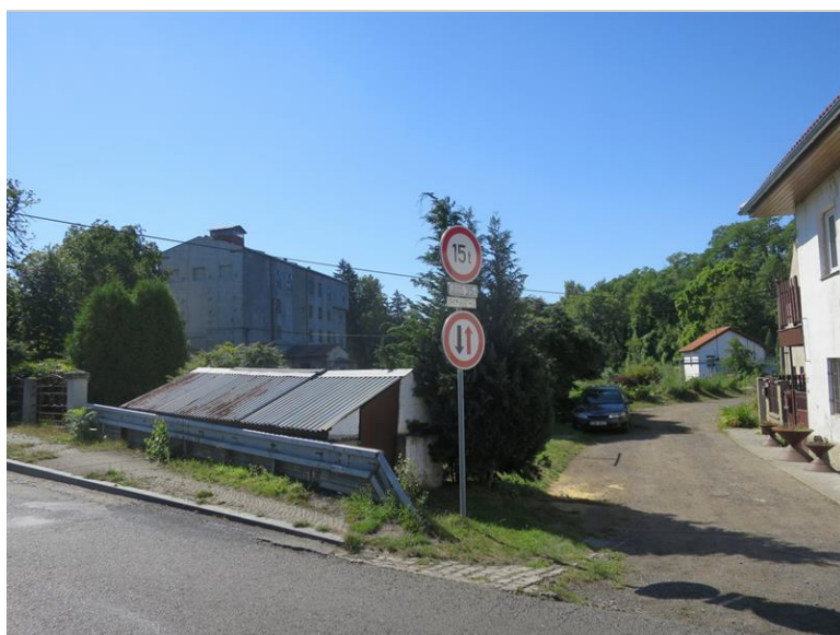
osazené dopravní značení
